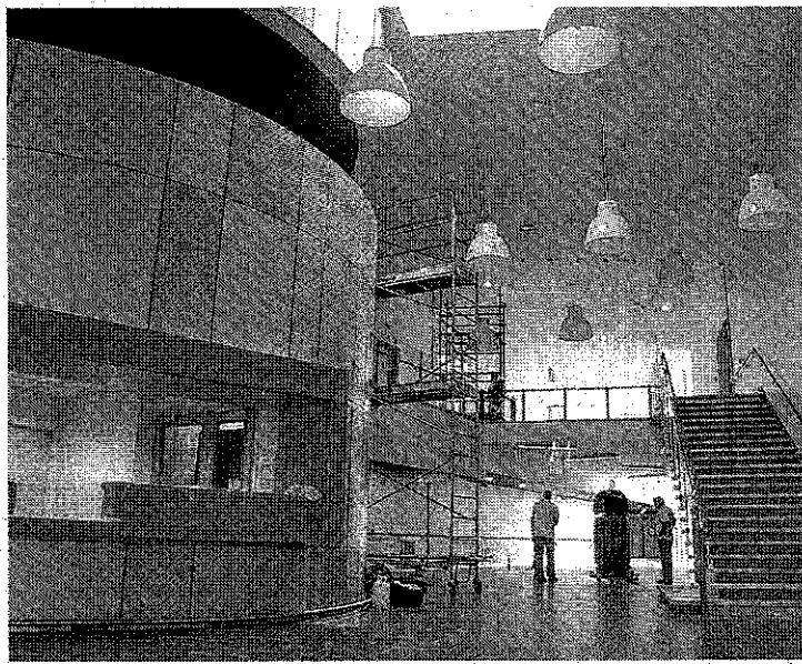
Dernières finitions dans le vaste hall de la nouvelle résidence « Val de Brenne », construite juste en face de Jean-Mercat.
