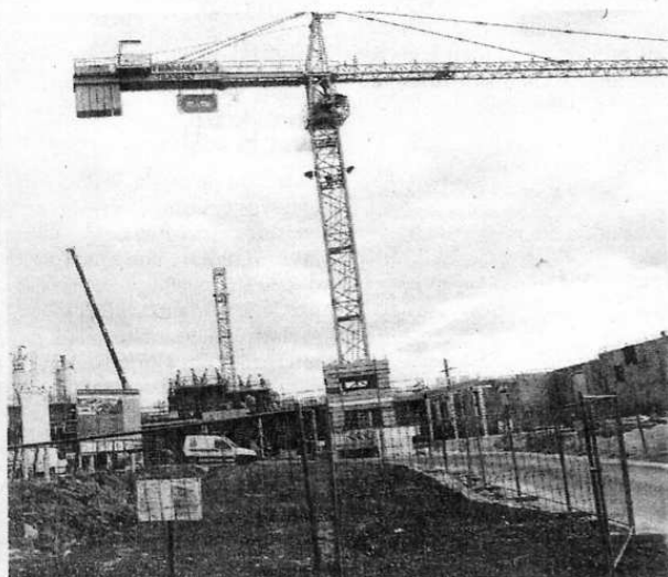
Des travaux de grande envergure.
